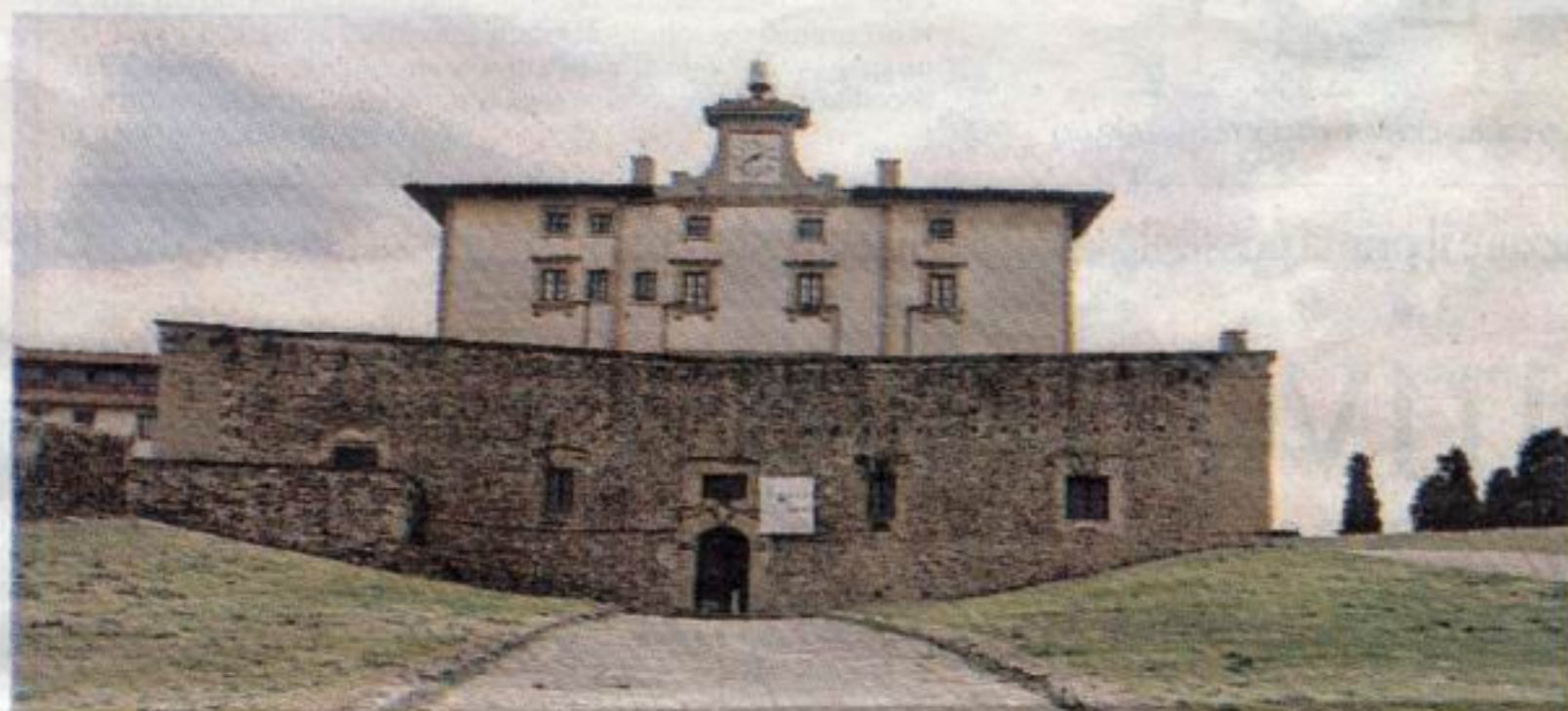
Forte Belvedere: Da Empoli vorrebbe poter riaprire la palazzina. Foto piccola sopra: il punto dell'incidente
